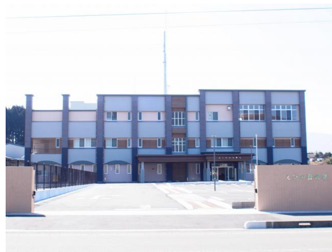
えびの警察署 給排水衛生設備工事 （単独工事） 平成 3 0 年 1 月
