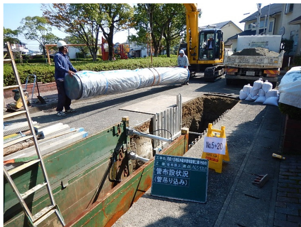
月見ヶ丘地区配水管 布設工事（J V） 平成 3 0 年 1 月
