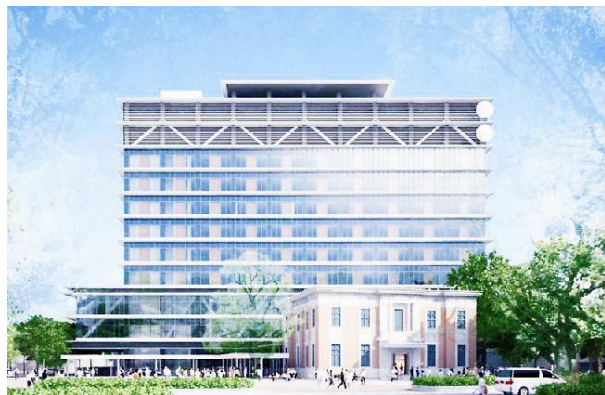
宮崎県防災拠点庁舎 建設空調工事（J V） 平成 3 1 年度完成予定
