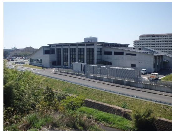
新富町総合交流センター 機械設備工事（J V） 平成 2 7 年 1 2 月
