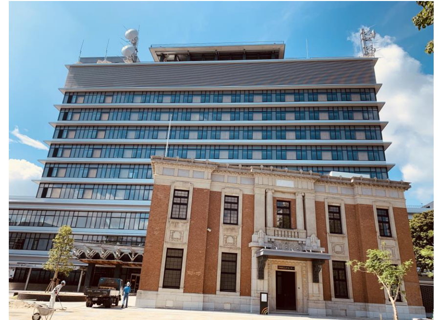
2020年8月完成 防災拠点庁舎(JV工事)
